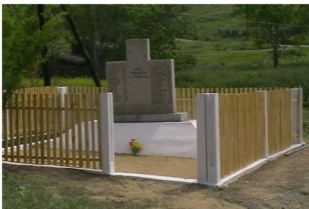
Июнь 2015г., 1-й этап реконструкции
