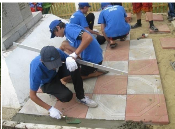
Июнь 2018г., 2-й этап реконструкции
